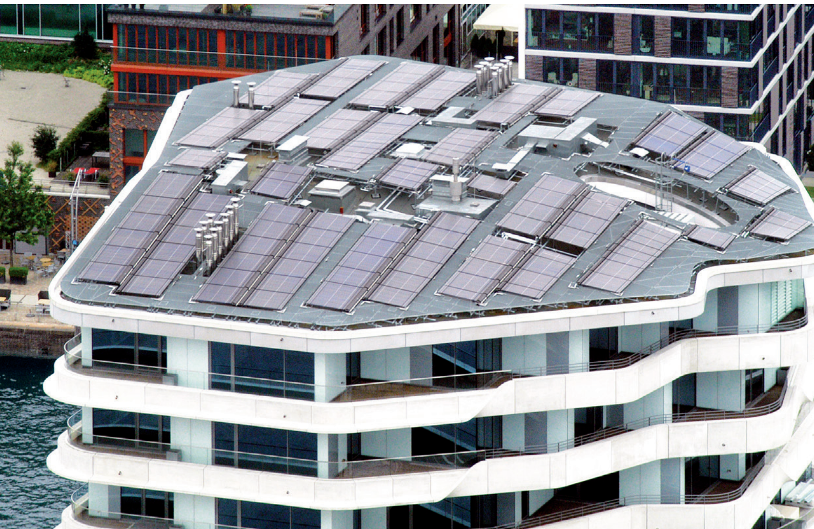
Installation solaire thermique sur la Marco Polo Tower de Hambourg
