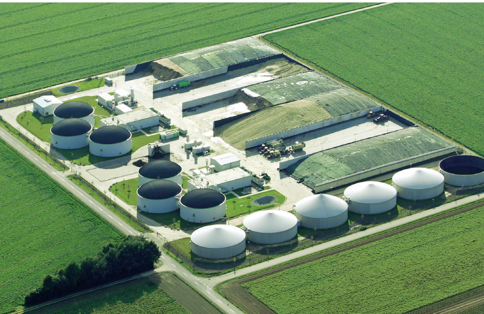
Installation de génération de biogaz par fermentation sèche
