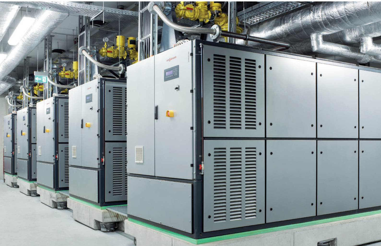
Centrale d'énergie avec cinq centrales de cogénération Vitobloc 200 (238 kW e /363 kW th )
