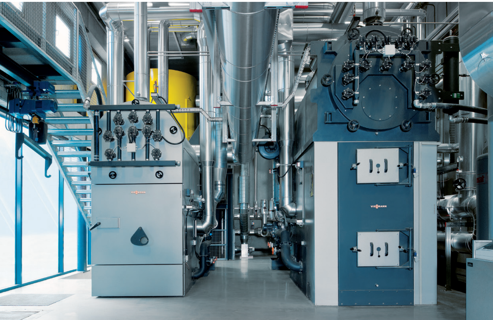
Vitoflex 300-RF – Chaudière bois innovante avec combustion tournante, pour granulés, plaquettes forestières et copeaux
