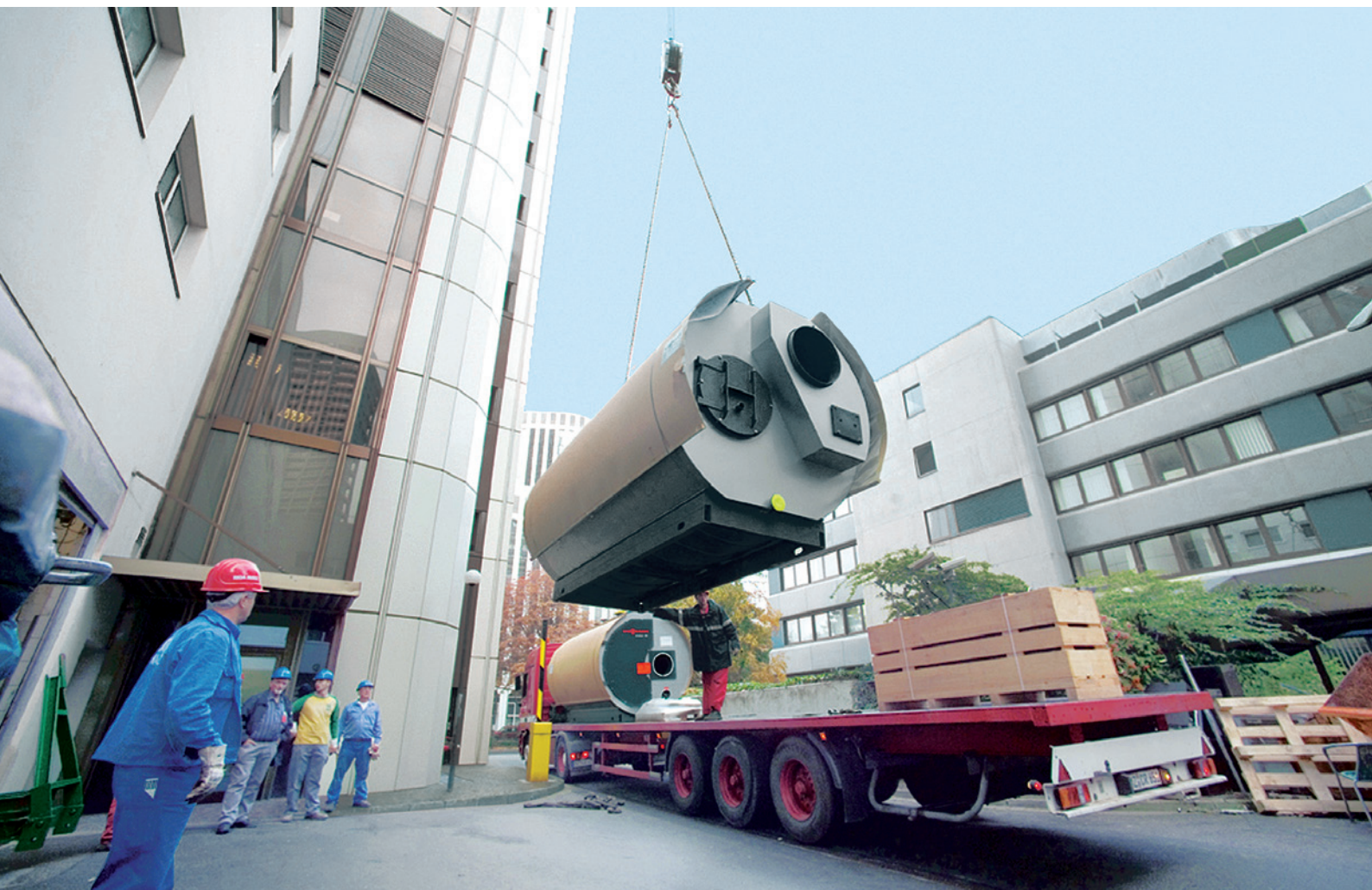
Livraison de générateurs thermiques Viessmann sur le chantier
